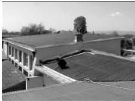
Novi krov na školi u Vrbovcu
