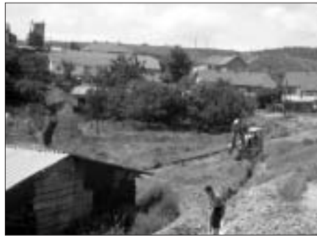
Nova vodovodna mreža u Staro Koloniji
