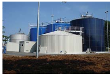
Biogas complex «Rassvet», 4,8 MW, Mogilev region
