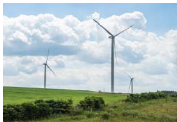
Wind power farm «Grabniki», 9 MW, Grodno region
