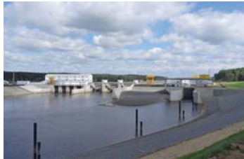
Vitebsk HPP 40 MW
