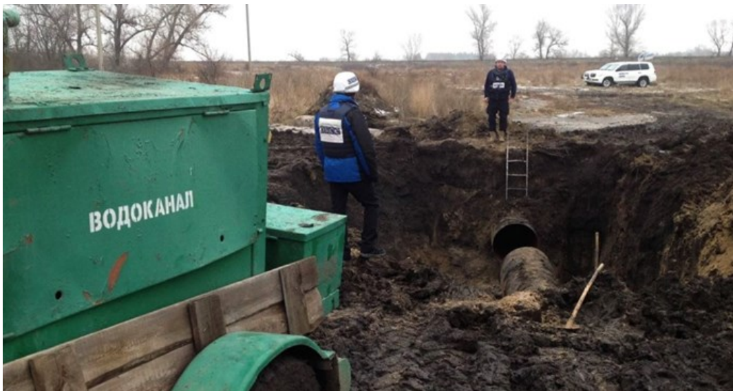
Наблюдатели СММ осуществляют мониторинг проведения ремонтных работ на водопроводе на востоке Украины (фото: ОБСЕ)
