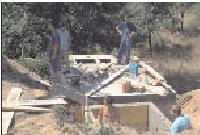
Stara Kolonija/Kolonija e Vjetër, the new sewage system
