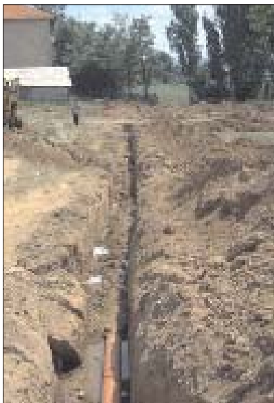
Stara Kolonija/Kolonia e Vjetër new water supply system
