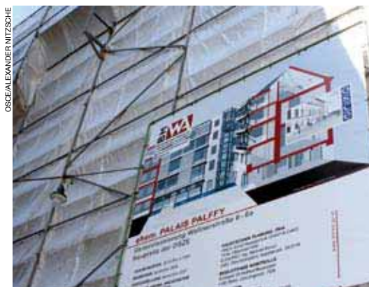
Le numéro 6 de la Wallnerstrasse fait l'objet d'une rénovation d'envergure.
