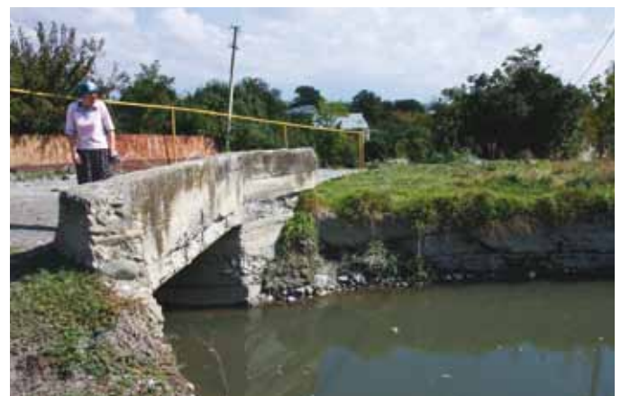
Dans le cadre du projet de gestion de l'eau d'irrigation de Nikosi, géré par l'OSCE, des pompes à eau et des conduites ont été installés pour alimenter le large canal d'irrigation de Saltvisi en eau douce, au profit des agriculteurs touchés par le conflit d'août 2008 en Géorgie. Juin 2011. (OSCE/Emmanuel Anquetil)
