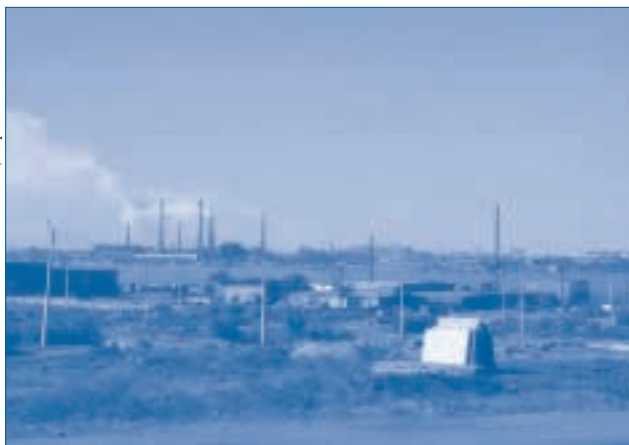
Завод в районе Балхаша
