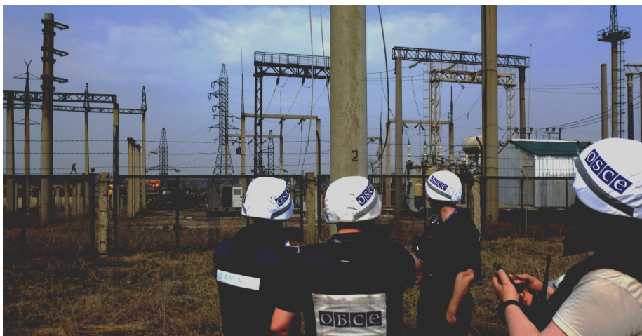
Спостерігачі СММ ОБСЄ сприяють встановленню режиму припинення вогню та здійснюють моніторинг його дотримання для уможливлення проведення робіт із розмінування та ремонту ліній електропередачі і підстанції поблизу ДФС між Авдіївкою та Ясинуватою, 4 квітня 2017 р. (ОБСЄ/Едвард Краузер)
