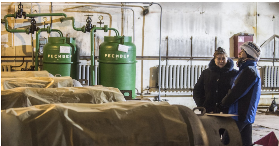
Спостерігачі ОБСЄ на Донецькій фільтрувальній станції (ОБСЄ/Свеен Малолетка)
