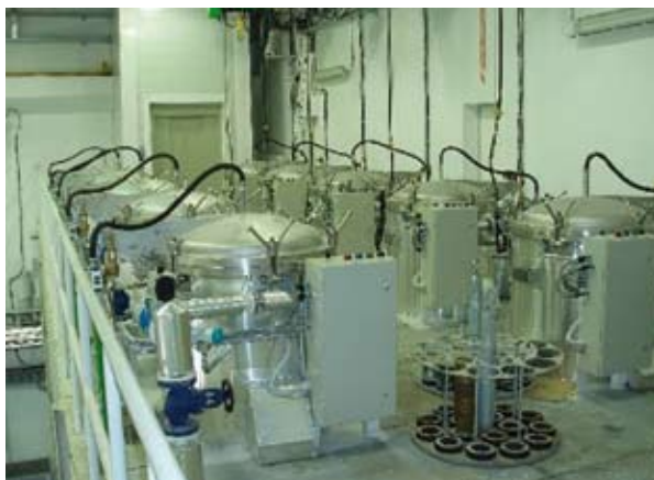
Abbildung 6.1: Ausschmelzen von TNT in Dampfkesseln in einem Werk für Kampfmittelbeseitigung in Ankara (Copyright NAMSA)
