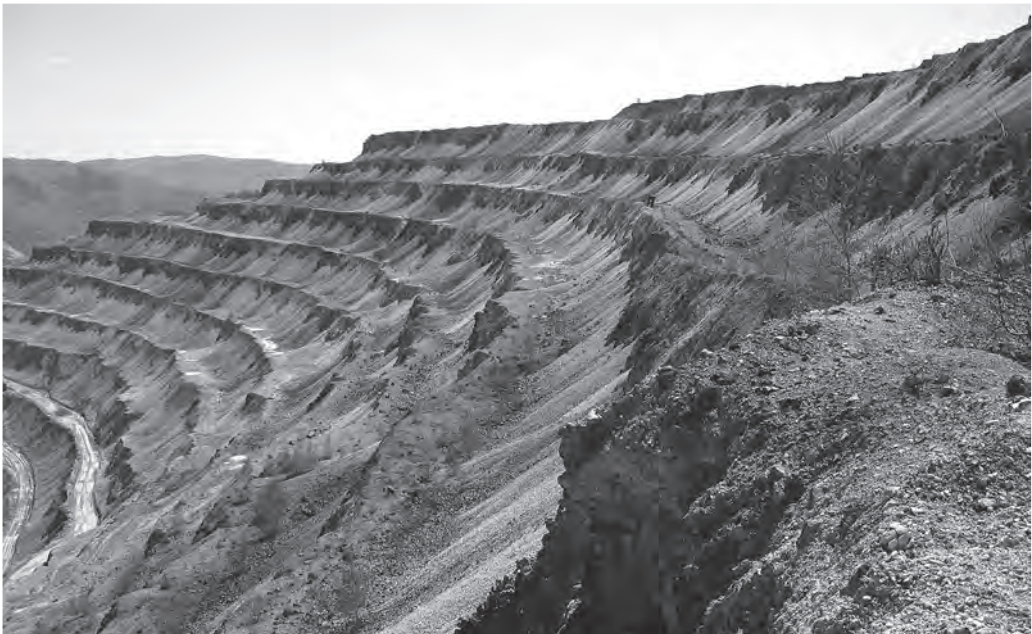
Ֆիզիկական և քիմիական էրոզիան պղնձի հանքի հորային պատի վրա: Լուսանկարը՝ Ֆիլիպ Փեկի:
