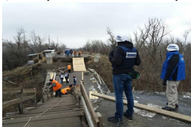
Ремонт дерев'яних конструкцій мосту в Станиці Луганській, 9 грудня 2017 року (ОБСЄ)
