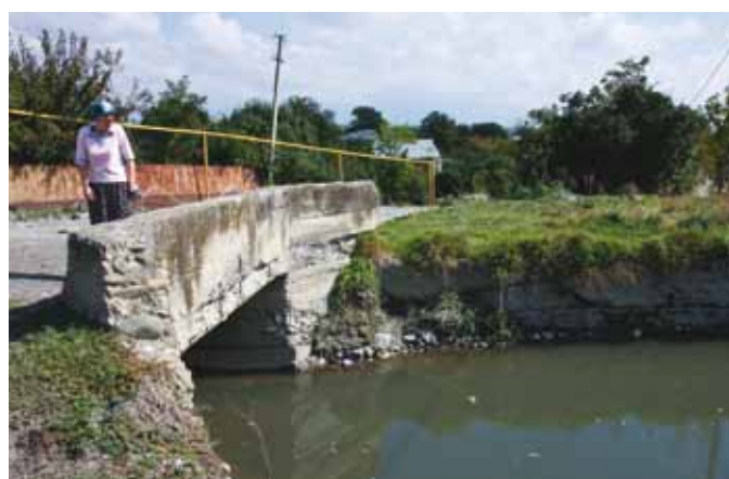
Das KVZ stellte im Rahmen des von ihm verwalteten Bewässerungsprojekts in Nikossi Wasserpumpen und -rohre zur Verfügung, über die Flusswasser in den großen Bewässerungskanal Saltwissi geleitet wird, von wo es zu den vom Georgien-Konflikt vom August 2008 betroffenen Bauern gelangt. Juni 2011 (OSZE/Emmanuel Anquetil)
