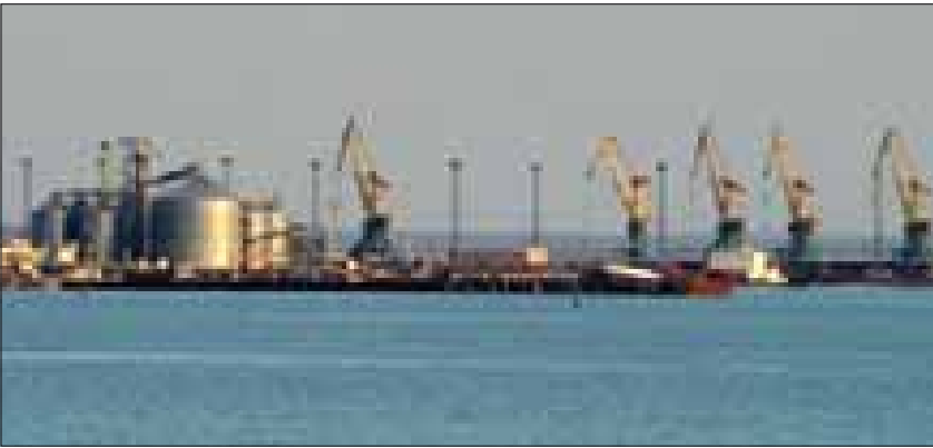
Нефтяная промышленность Казахстана: нефтеналивные сооружения на Каспийском море.
