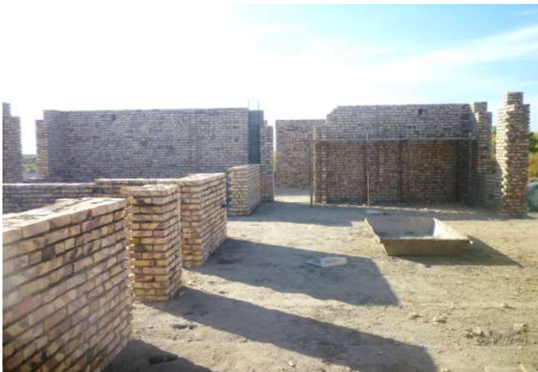
Рис 68. Строительные работы на Муйнакской биостанции (сентябрь-октябрь 2023)
